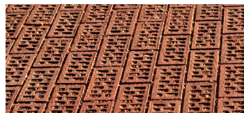
> exemple de paviment ceràmic amb junta oberta
